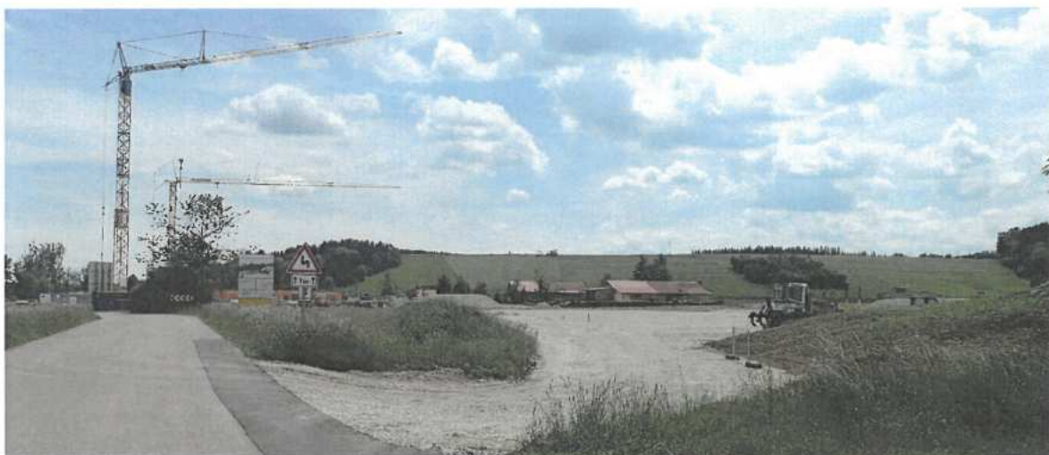
Abb. 57 Blick vom Buchweg auf die Baustelle des BVZ; Quelle: Planungsverband; Aufgenommen im Juni 2020
